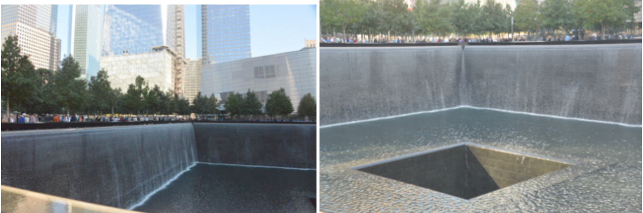
Auf dem Fundament der alten Türme errichtet, viereckiger Wasserfall, 9 Meter tief, danach fällt das Wasser ins Loch in der Mitte.
